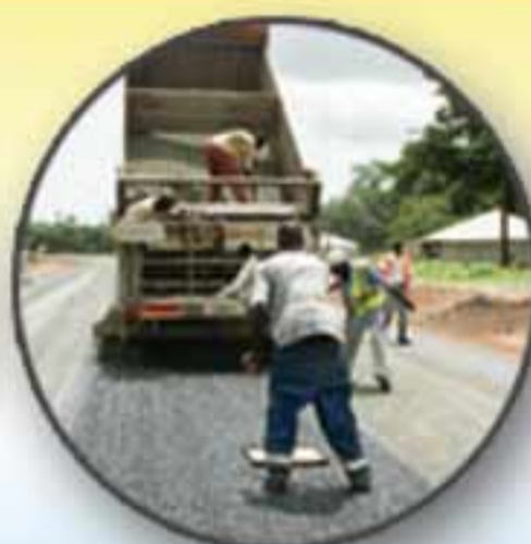
Aménagement de chaussées
